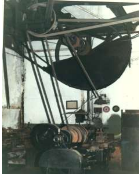
Şekil 1.12 Transmisyon Sistemiyle gücün tezgahlara aktarımı
